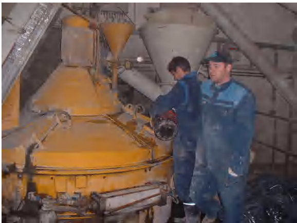
Blöndun í steypustöð
