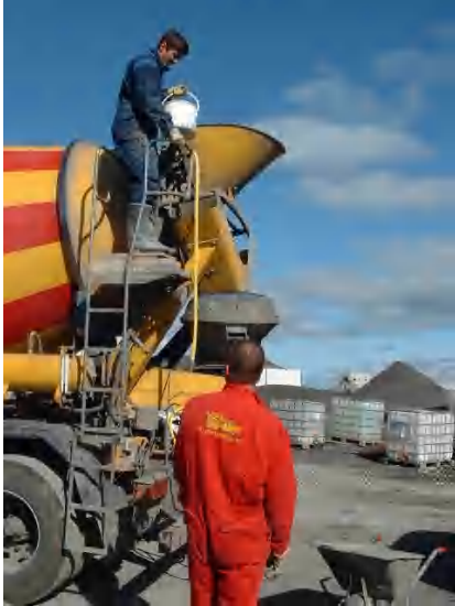
Glenium bætt í steypu
