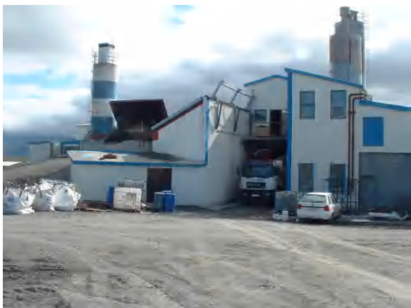
Steypustöð Loftorku í Borgarnesi.
